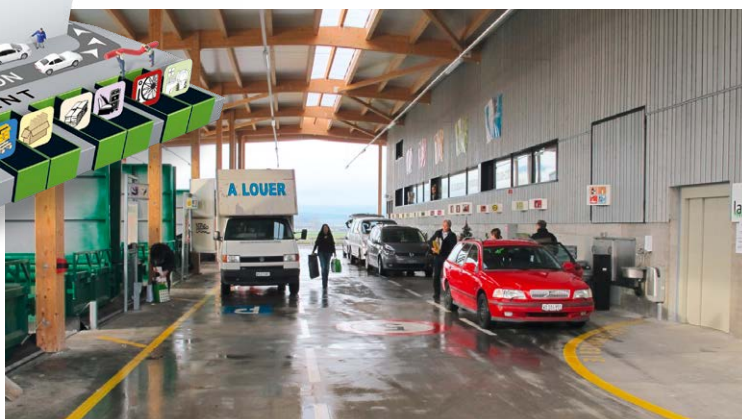
Plateforme de déchargement de la nouvelle déchèterie
