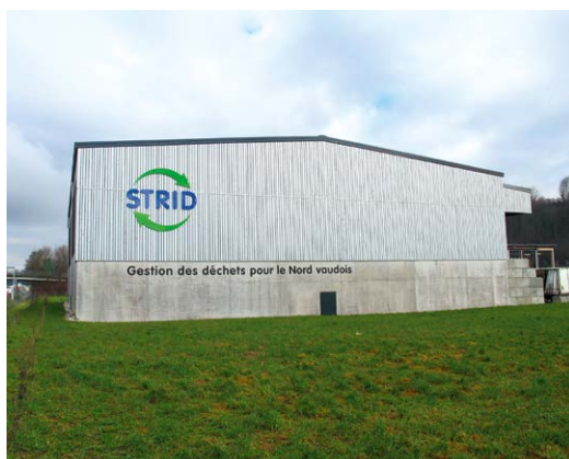
Nouvelle halle de transfert sur le site de Champs Torrens
