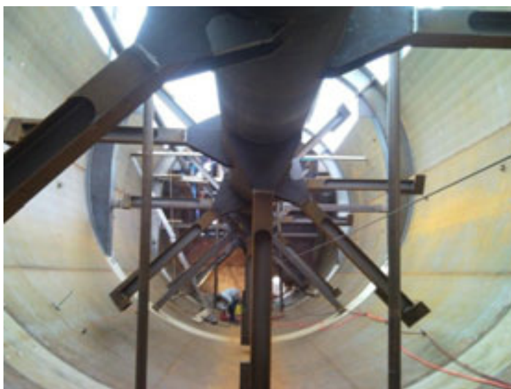
Intérieur du digesteur en construction
